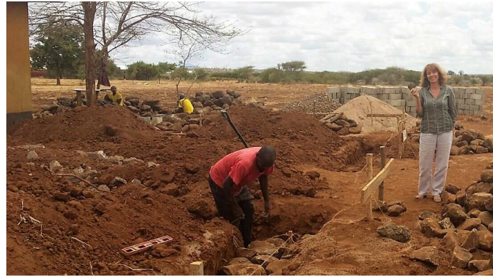
Die Fundamente werden in Handarbeit ausgegraben. Maschinen stehen den Arbeitern keine zur Verfügung.
