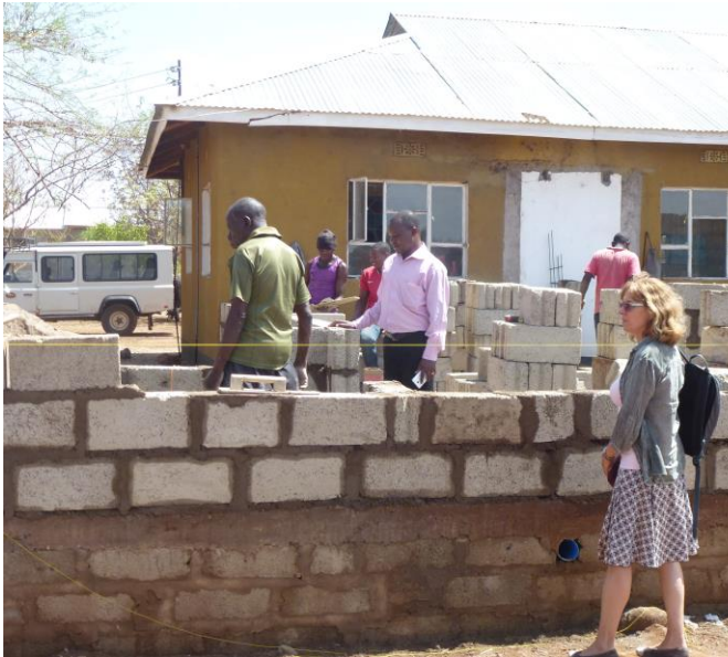
DMO Benela besichtigt die Baustelle.
