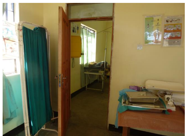
Türe vom Entbindungszimmer zum Ruheraum.
