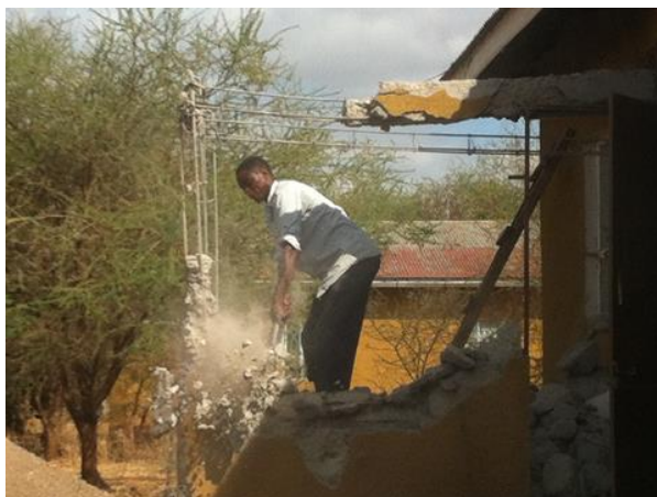
Die Bauarbeiten beginnen mit dem Abbruch eines kaputten Anbaus.
