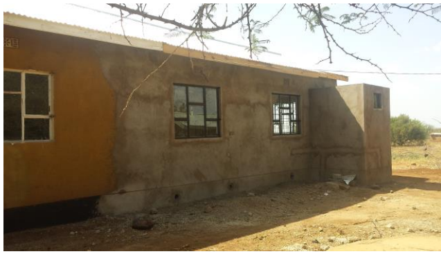
Auf der rechten Seite des Gebäudes sieht man den Toilettenanbau am neuen Entbindungszimmer. Auf das Dach kommt später noch ein 1000 L Wassertank.
