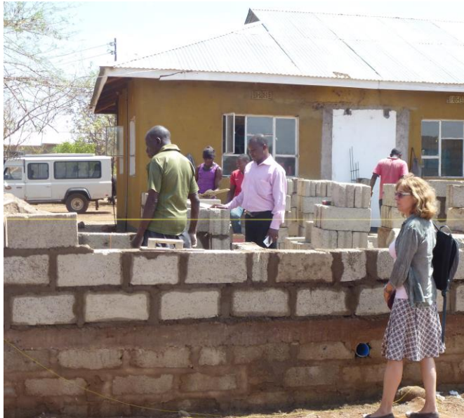
DMO Benela besichtigt die Baustelle.
