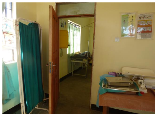
Türe vom Entbindungszimmer zum Ruheraum.
