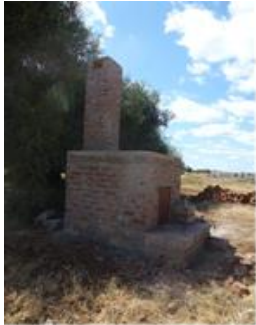
.... und hier der Nachbau für die Gesundheitsstation in Makuyuni.
