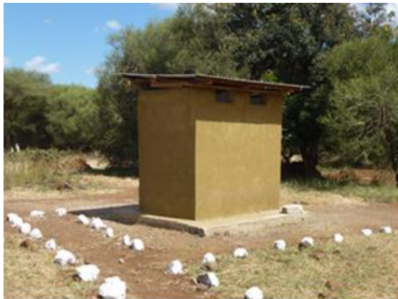
Durch sparsames Wirtschaften konnten sowohl Toiletten für Personal und Patienten sowie eine extra Toilette-Dusch-Einheit für das Entbindungszimmer gebaut werden.
