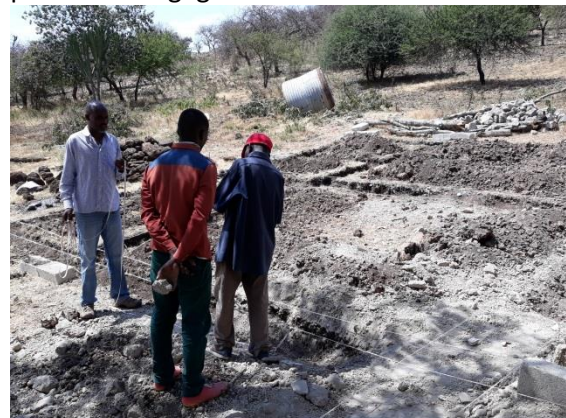
Vor Ort wird gemessen und das Fundament per Hand ausgegraben
