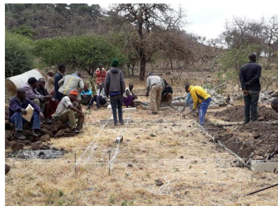
Vor Ort wird gemessen und das Fundament per Hand ausgegraben
