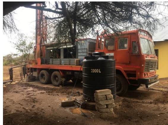
Am Tag vorher wurde die Gerätschaft herangeschafft und positioniert
