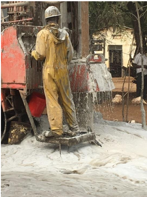
Um tiefer zu bohren und durch das Gestein zukommen wird Seifenlauge zugesetzt.
