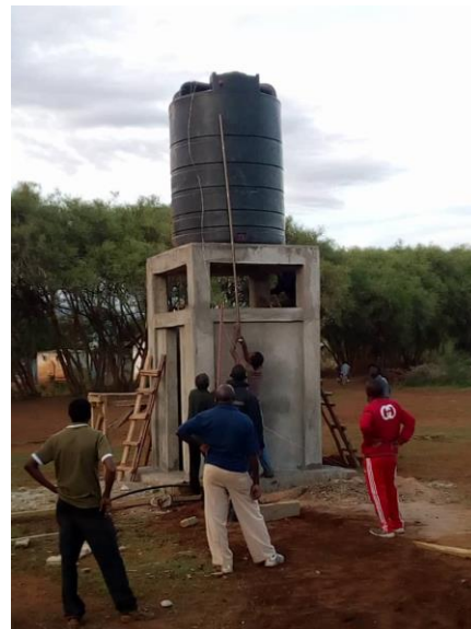
Mit zwei Leitern und gemeinsamer Anstrengung wird der schwere 5000 l Wassertank auf den Turm gehievt. Beeindruckend, wie etwas möglich ist, was unmöglich scheint ;-).
