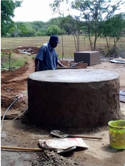
Bauleiter Maruchu, mit dem wir in Makuyuni seit Anfang an sehr gut zusammen arbeiten, baut das Fundament für den 2000 Liter Tank vor der Kirche.
