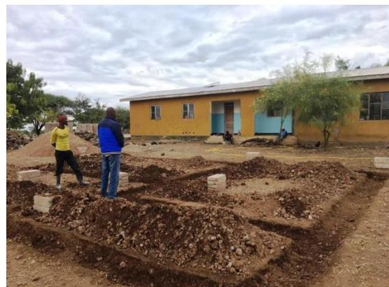
Das Fundament für das neue Gebäude wird vorbereitet. Im Hintergrund ist die alte Gesundheitsstation
