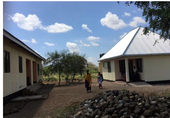
Links die renovierte Gesundheitsstation und rechts das neue Entbindungshaus
