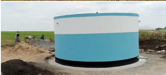
Das neue Wasserreservoir
