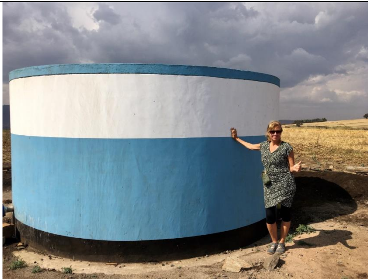
Wassertank, von wo das Wasser verteilt wird.
