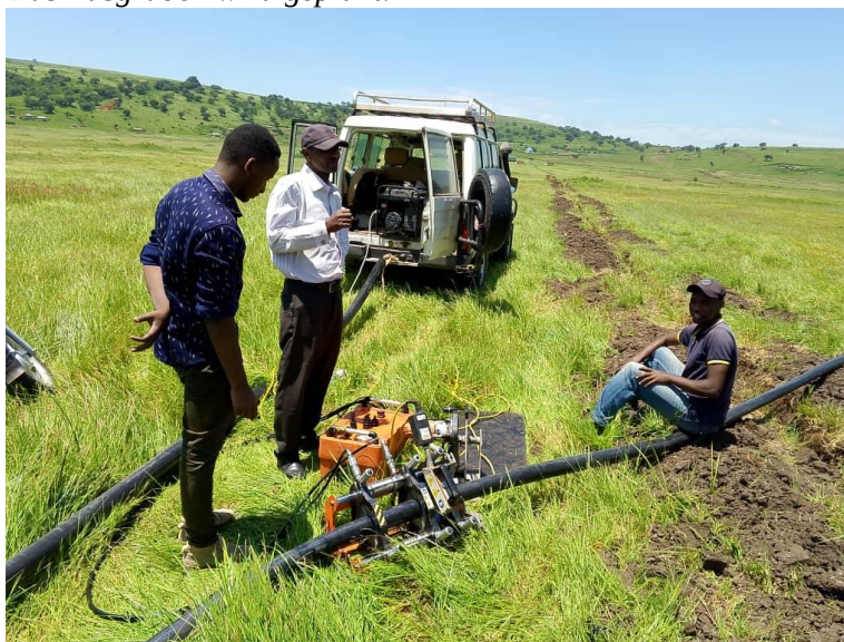
Verlegen der Wasserleitungen
